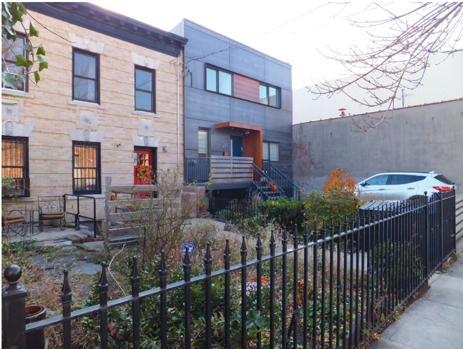
II. 8. Budynki mieszkalne jednorodzinne po przebudowie (fot. J. Huebner)
