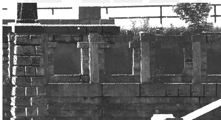
Rys. 9. Inwentaryzacja ubytków w spoinach wykonana na podstawie chmury punktów wraz z określeniem głębokości szczelin Fig. 9. The inventory of weld defects with measurements of crevices depth made on cloud of points
