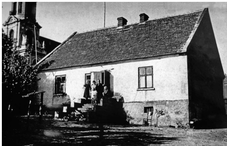
Fot. 1. Budynek starej szkoły (okres międzywojenny) Źródło: zbiory Marka Bucikiewicza
