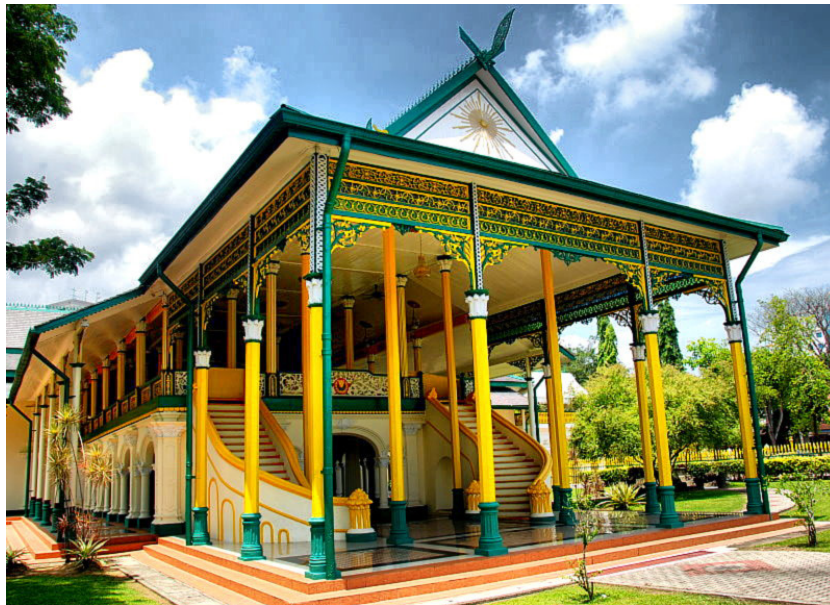
Fig. 2.3a. The present renovated Balai Besar demonstrate the use of kolong and combination of bumbung limas/panjang Rys. 2.3a. Balai Besar wykazuje użycie kolongu w połączeniu z bumbung limas/panjang
