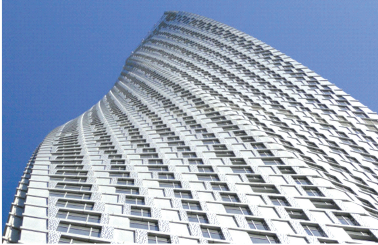
II. 3. Widok pokazujący skrzywienie elewacji budynku Cayan Tower w Dubaju, wg https://jedenraz.wordpress.com/2016/04/17/cayan-tower-pomnik-racjonalnego-myslenia-w-sluzbie-sztuki-i-handlu/ , dostęp: 20.08.2018
