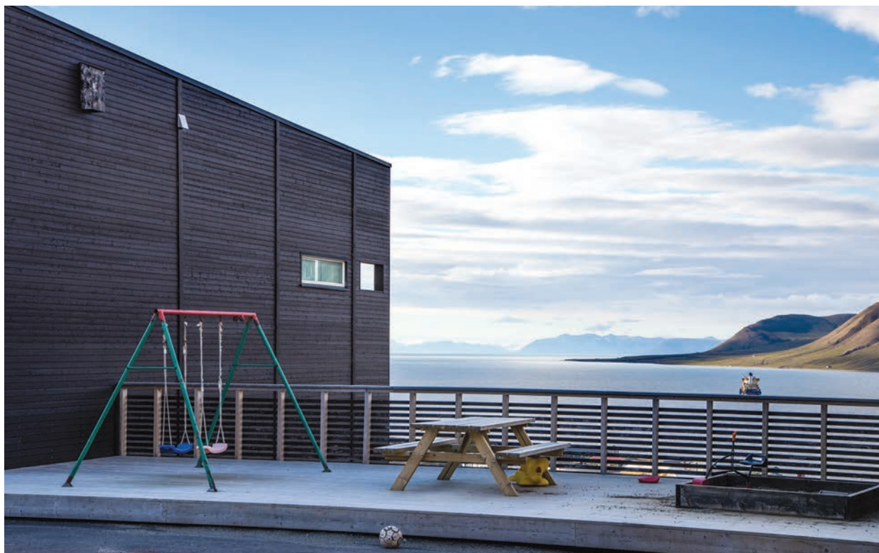
Fot. 3. Przestrzeń wspólna między zabudową mieszkaniową z widokiem na fiord Adventfjorden. fot. Agnieszka Żabicka, 2016 Photo 3. Common spaces between residential buildings overlooking the Adventfjorden Fjord. Photo by Agnieszka Żabicka, 2016
