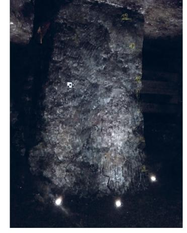
Fig. 1. Cracks of the pillar in the Inanimate Nature Reserve Crystal Grottoes in Salt Mine Wieliczka, authors' own archive Rys. 1. Pęknięcia filaru w rezerwacie przyrody Groty Kryształowe w Kopalni Soli w Wieliczce, źródło: archiwum autorów
