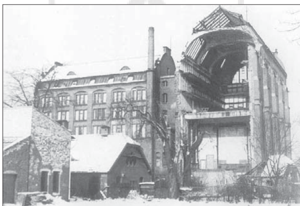
Il. 9. Budynek muzeum w 1948 r. – lewe skrzydło z pozbawionymi ścian szczytowych salami wystawowymi (fot. S. Bednarz)
