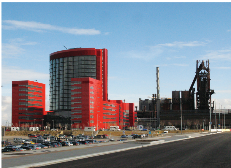
Il. 2. Współczesny landmark dzielnicy Nowe Belval – biurowiec Dexia Belval. Present-day landmark of the new district New Belval – an office building Dexia Belval (źródło: https://commons.wikimedia.org/wiki/File:Dexia_Belval.jpg autor Les Meloures; dostęp: 25.03.2018)
