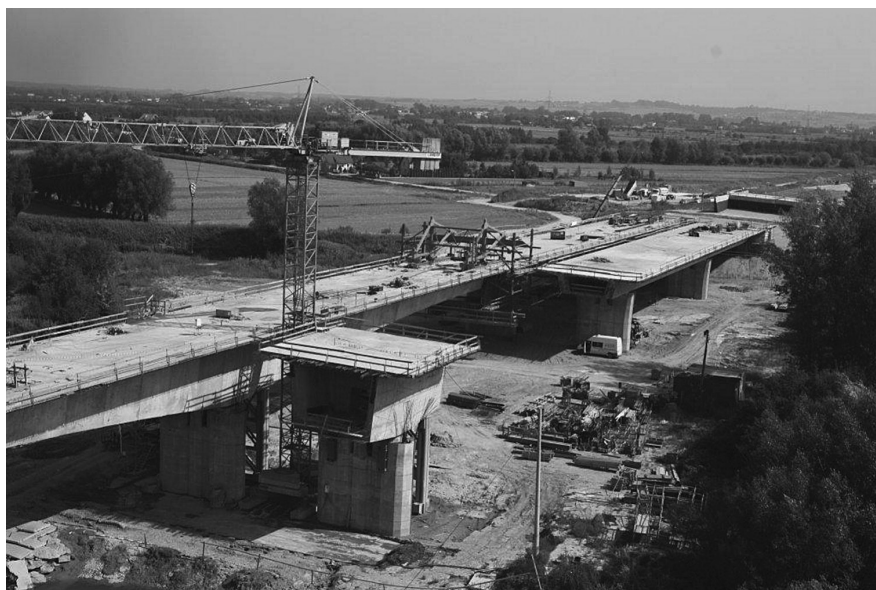
Rys. 3. Widok badanego obiektu
