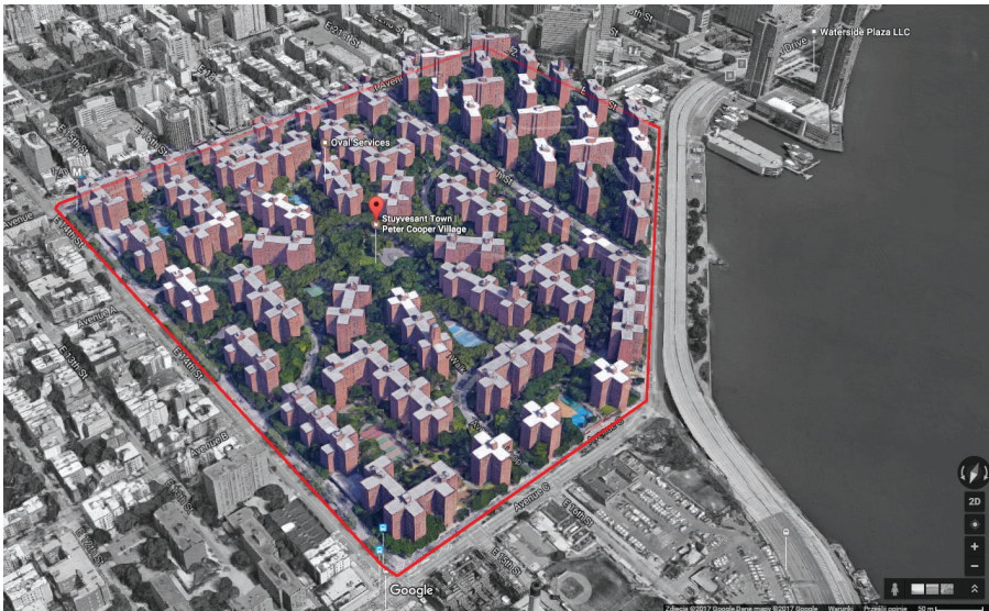
II. 25. Grafika ze zdjęciem satelitarnym z 2017 roku przedstawiająca na trójwymiarowym ujęciu charakter i strukturę zabudowy Stuyvesant Town – Peter Cooper Village, Manhattan, Nowy Jork, USA (źródło: www.google.pl/maps )
