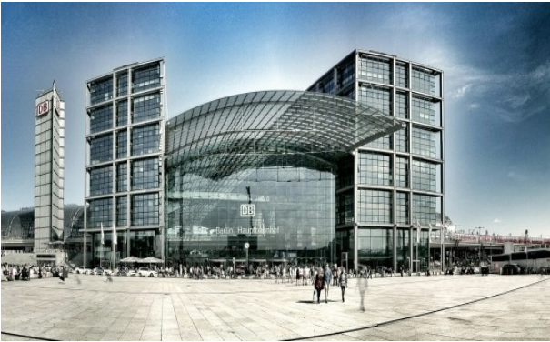
Fig. 4. Berlin Hauptbahnhof station.
