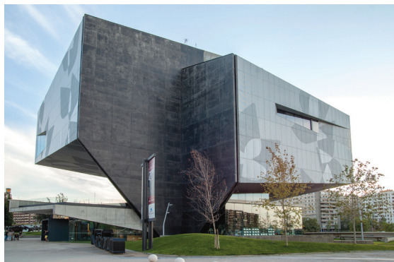
II. 5. Caixaforum Saragossa (fot. P. Broniewicz)
