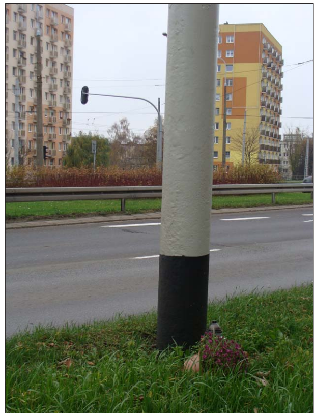
Ryc. 3. Ul. Morska, Gdynia, listopad 2013
