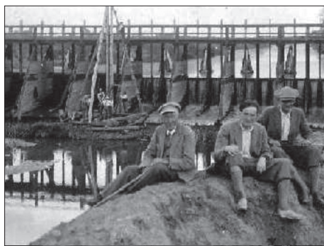
Budowa jazu na rzece Wiszni, 1932 r. źródło: http://rozwadowski.org/v2.0.1.2/index.php/2015/07/21/w-nowostawach-1930-1939/
