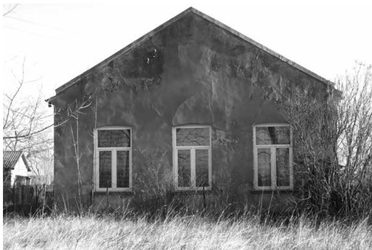
2. Budynek dawnej Szkoły Powszechnej w Wiesiołowie. Stan obecny Foto: Autor
