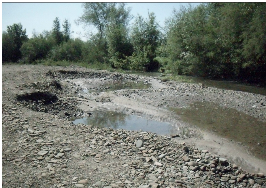
Fot. 6. Ślady po nielegalnej eksploatacji żwirów (odcinek 9) Photo 6. Sites of illegal gravel extraction (section 9)
