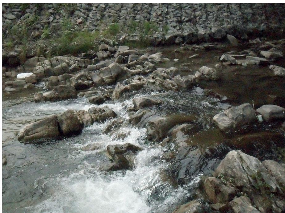
Fot. 2. Skalne progi pod mostem w Klikuszowej (odcinek 6) Photo 2. Rocky step under the bridge in the town of Klikuszowa (section 6)
