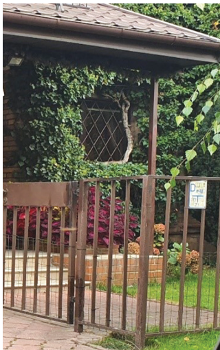
il. 2. Ściana budynku z zainstalowaną konstrukcją wsporczą dla pnączy. Zdjęcie J. Klimowicz lipiec 2019
