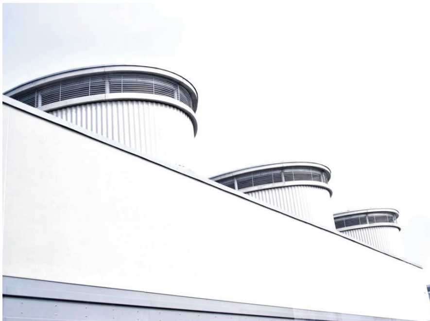
Il. 1. Kominy na dachu Cedetu (fot. Klaudia Obrębska)
