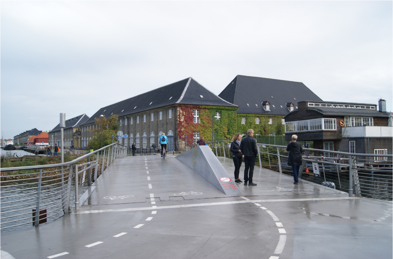
Ryc. 6. Infrastruktura rowerowa i piesza na moście zwodzonym Trangravsbroen.
