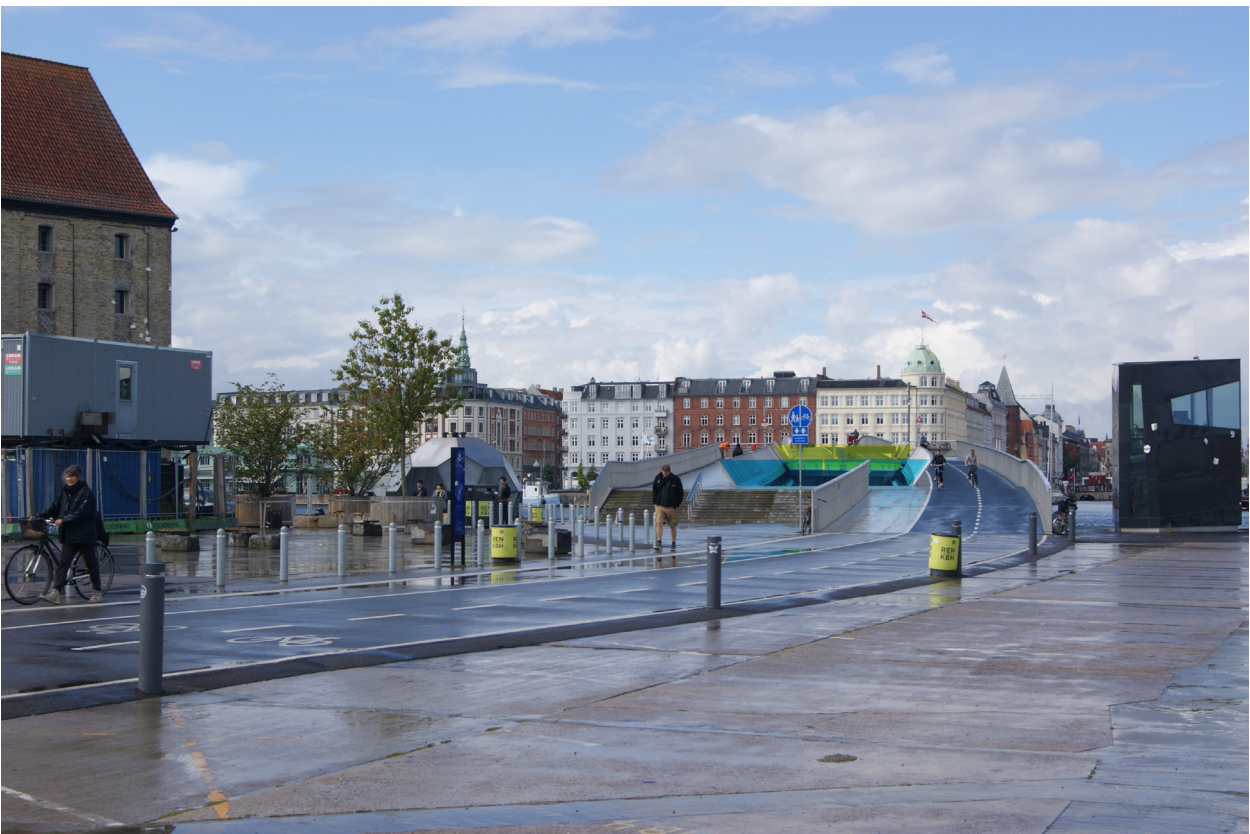
Ryc. 7. Infrastruktura rowerowa i piesza na moście Inderhavnsbroen.
