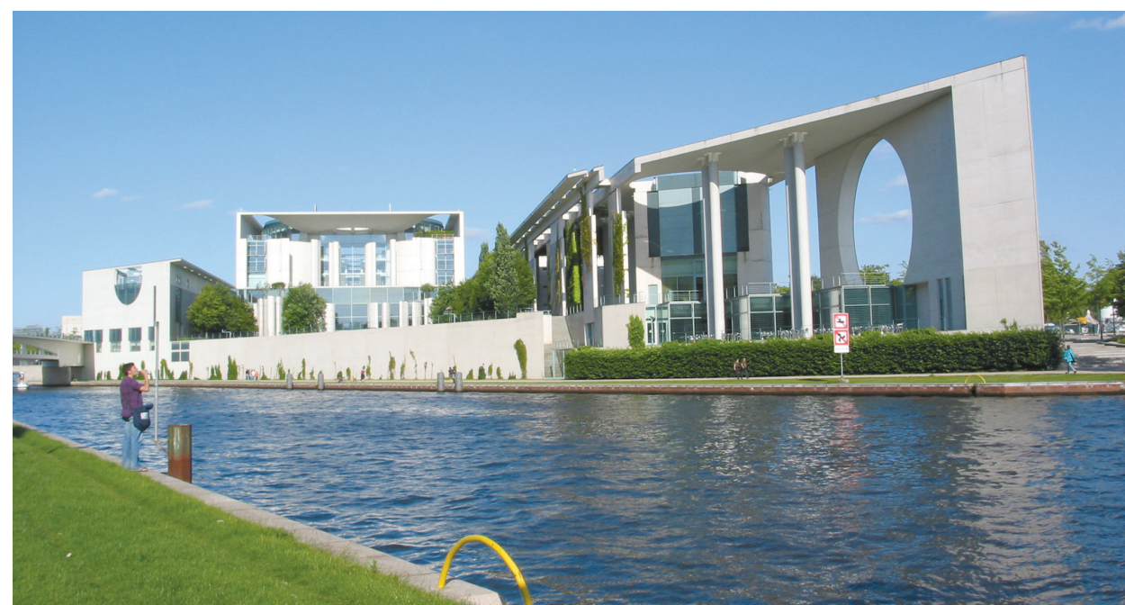
Il. 4. Zespół Spreebogen, Berlin, fot. K. Pluta 2010 / Spreebogen Complex, Berlin, photo K. Pluta 2010
