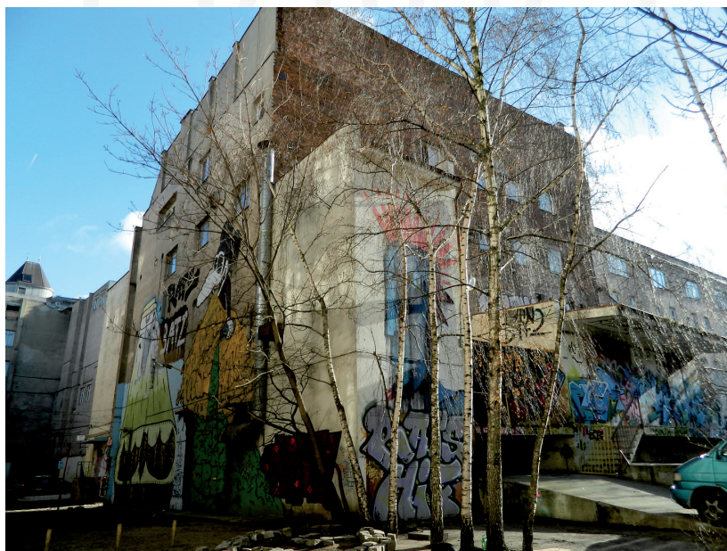
III. 10. “Personalized” backyards at Ruska, Włodkowica and Św. Antoniego Streets (Wrocław). Source: D. Chylińska (2013)
