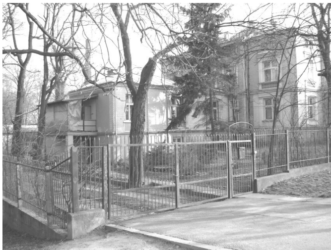
Il. 2. Pałac Briggsów wraz z bezpośrednim otoczeniem odseparowany od parku ogrodzeniem – teren szkoły niedostępny dla użytkowników parku. Fot. K. Kimic, 2014
