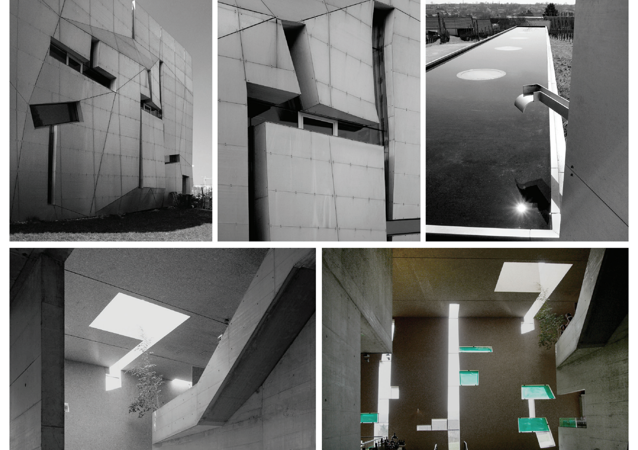
Il. 2. Elewacja i wnętrze Loisium, proj. Steven Holl / The facade and interior of the Loisium, design by Steven Holl
