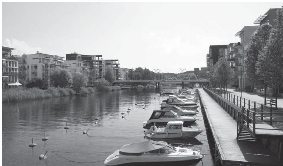
il. 1. Hammarby Sjöstad, Sztokholm – nadbrzeża przystosowane do cumowania łodzi w dzielnicy mieszkaniowej. (fot. autor) / Hammarby Sjöstad, Stockholm – watersides adapted to the docking of boats within a residential district. (Phot. By the Author)
