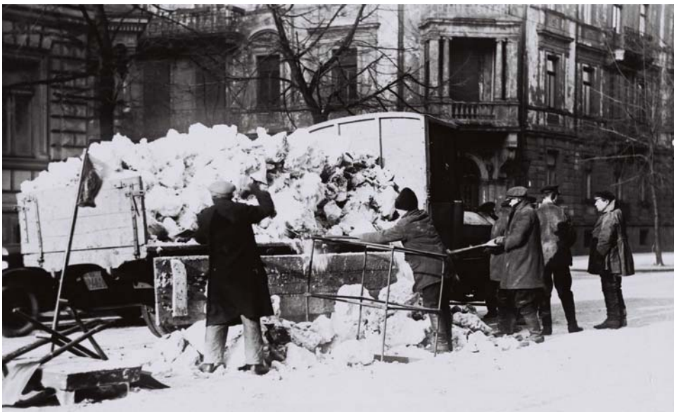
Ryc. 5. Ciężarówka TiAM, parkująca zapewne od 1930 r. w zajezdni „Łazienkowska”, przebudowana z autobusu piętrowego marki Saurer (nr rej. W 18459, nr tab. /?/2), podczas prac związanych z usuwaniem śniegu z ulic Warszawy. Zrzut śniegu do burzowca w Alejach Ujazdowskich. Za ciężarówką z lewej kamienica spod numeru policyjnego 41, z prawej Wilcza 2/4. Widoczni bezrobotni zatrudnieni do rozładunku oraz kierowcy z TiAM i pracownicy Wodociągów. Przy barierkach powiewa proporzec z logo „Wodociągów Warszawskich”, styczeń 1927 r. (fot. NAC syg. 1-G-6684).
