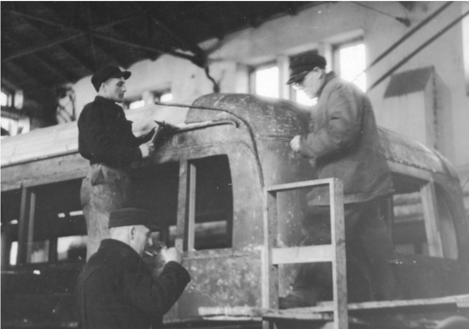
Ryc. 10. Nad dachem remontowanego trolejbusu JaT B-2 widoczna więźba dachowa murowanej hali, wzmocnienia wewnętrzne murów i okna od północy. Na ujęciu widoczni podczas pracy trzech pracownicy zaplecza technicznego. Około 1948 r. (fot. NAC, sygn. 3-654.10).
