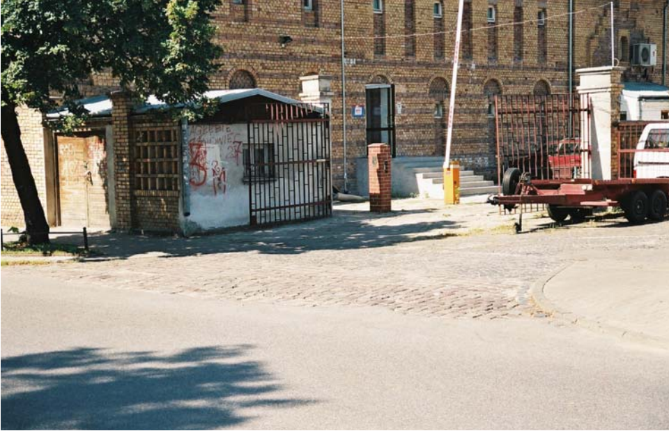
Ryc. 29. Pozostałość po zajezdni w postaci wyjazdu z kamienia polnego gładzonego oraz czarnej kostki bazaltowej, stan z 21 sierpnia 2009 r. (fot. M. Dziubiński).
