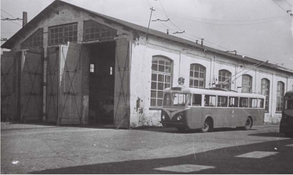
Ryc. 9. Front murowanej hali i sfotografowana część ściany z początków istnienia zajezdni, widoczny francuski trolejbus marki Vepra nr tab. 34 (z linii 54), obok fragment radzieckiego JaT B-2. Na placu widoczny cień z oczodołami okien wypalonego budynku administracyjnego. Zdjęcie wykonane w latach 1948–1949 (fot. Dyrekcja Miejskich Zakładów Komunikacyjnych. Sprawozdanie za okres 1945–1949 ).
