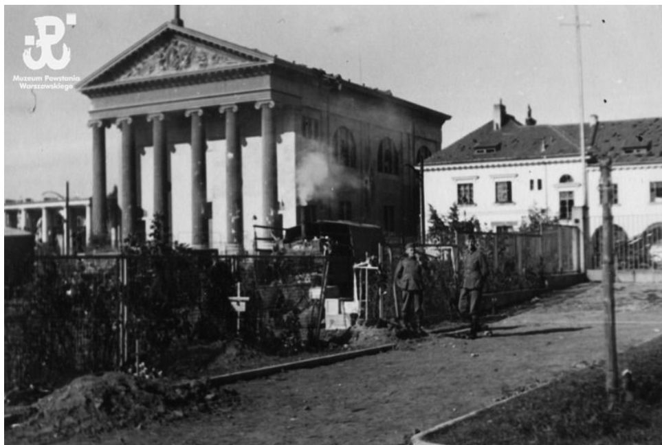
Ryc. 15. Październik 1939 r., żołnierze niemieccy przy kuchni polowej, w tle zajezdnia, widoczna uszkodzona dachówka, pozbawione szyb okna, na kościele ślady ostrzału i bezpośrednie trafienie. Widoczne słupy trakcyjne tramwajowe. Na pierwszym planie groby (fot. MPW, sygn. MPW-IP.6358).
