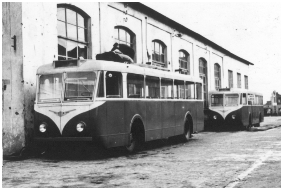
Ryc. 18. Murowana hala warsztatowa, ściana południowa. Widoczne za przygotowanymi do eksploatacji trolejbusami francuskimi marki Vetra trzy okna dobudowane po 1945 r. Przy drugim trolejbusie znajduje się zakryty blachami kanał rewizyjny. Zdjęcie wykonane najprawdopodobniej ok. 7 kwietnia 1948 r. (fot. NAC, sygn. 3-651.3).
