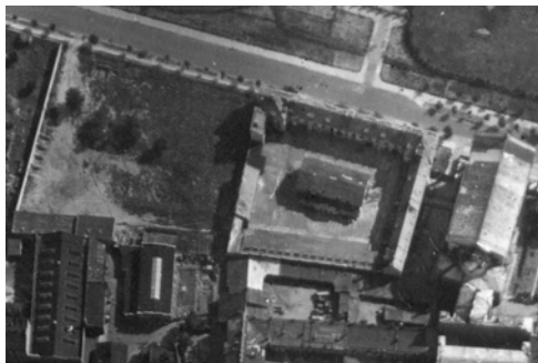
Ryc. 16. Ostatnie chwile istnienia zabudowy przy Łazienkowskiej 8. Niemiecki zwiad lotniczy utrzymał ten obiekt w obiektywie aparatu 30 sierpnia 1944 r. Pusty teren po lewej stronie wygradzony murem stanie się po wojnie terenem zajezdni trolejbusowej (fot. National Archives College Park, USA).
