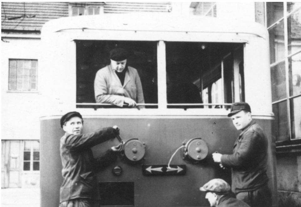
Ryc. 12. Ocalałe w najlepszym stanie po pożodze wojennej skrzydło zachodnie, widoczna ściana wschodnia, stan z początków kwietnia 1948 r. Za pracownikami zajezdni i przygotowanym do eksploatacji nowym trolejbusem marki Vetra dawny garaż, zamieniony na pomieszczenie warsztatowe. Widoczne przedwojenne detale architektoniczne, takie jak świetlik dachowy i okno, zachowane w niezmienionym kształcie (fot. NAC, sygn. 3-651.5).
