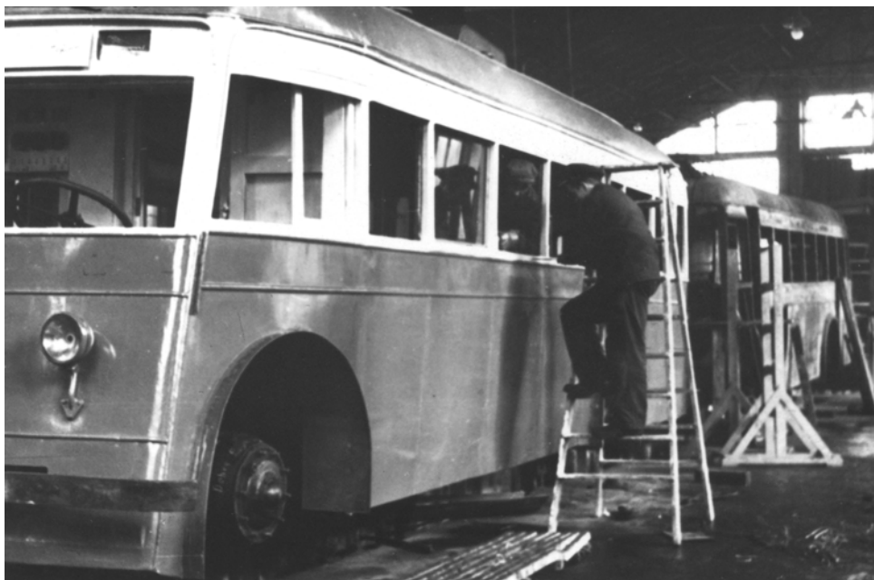
Ryc. 25. Radziecki trolejbus w trakcie generalnego remontu, lśniący nowym lakierem. Wyposażanie pojazdu. Zapomniany i niedoceniany, okres pełen poświęcenia pracowników przedsiębiorstw komunikacyjnych w powojennej biedzie i nowej komunistycznej rzeczywistości. Pod trolejbusem widoczny kanał (fot. NAC, sygn. 3-651.6).
