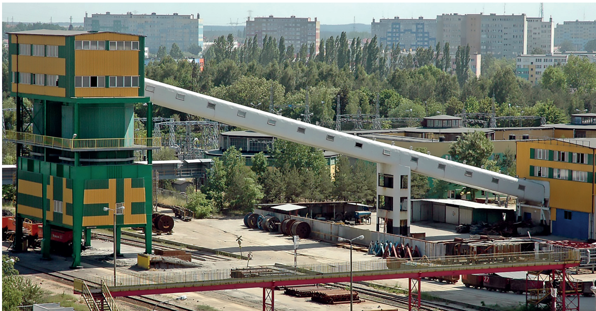
Fig. 1. The conveyor gallery – view from the north. On the left: the ore haulage building, on the right: a fragment of the shaft building Rys. 1. Galeria transportowa – widok od strony północnej. Po lewej budynek odstawy rudy, po prawej fragment budynku nadszybia
