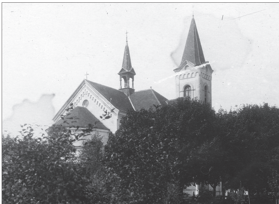
Nisko. Kościół po odbudowie. Narodowe Archiwum Cyfrowe
