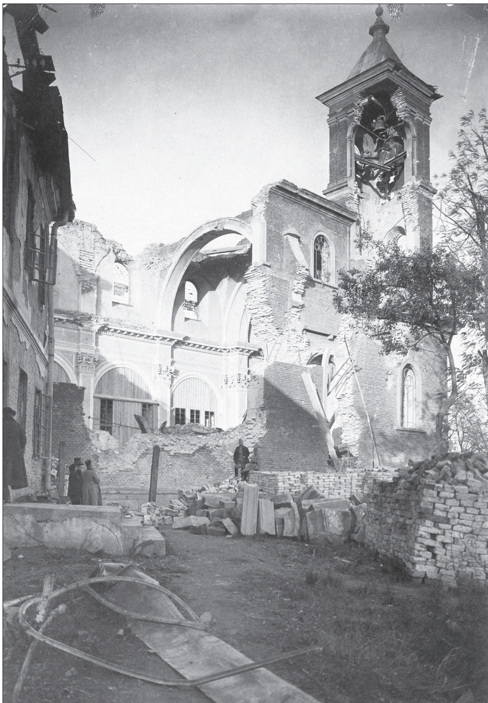
Gorlice. Zniszczony kościół. Narodowe Archiwum Cyfrowe
