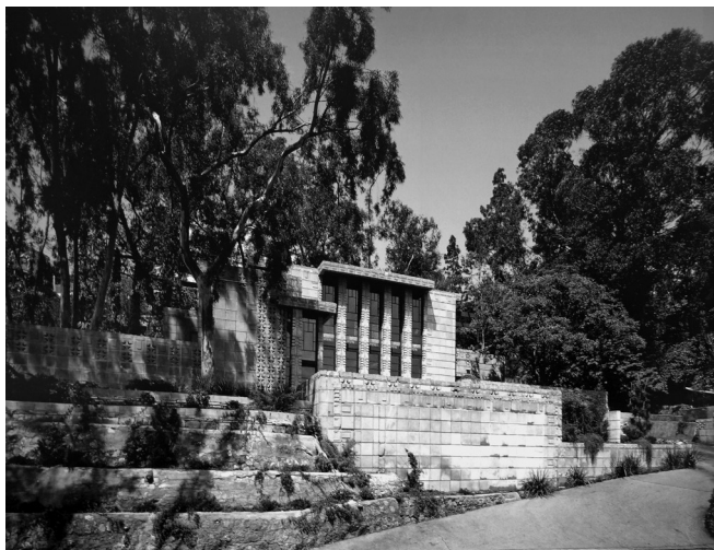
II. 8. Dom Johna Storera, Los Angeles, Kalifornia, 1923 – ogólny widok z południa (fotografia: Julius Shulman, 1985/źródło: [7] 110)
