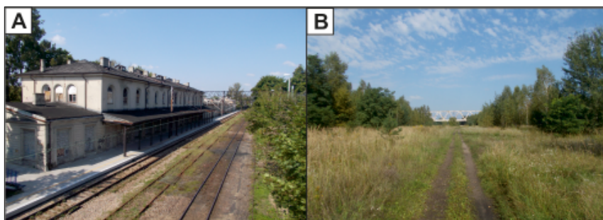
Fot. 2. Dworzec kolejowy Sosnowiec Maczki (A) i dawna stacja linii szerokotorowej (B) (fot. W. Dragan) Photo 2. Sosnowiec Maczki railway station (A) and former station of the broad gauge railway (B) (photo by W. Dragan)
