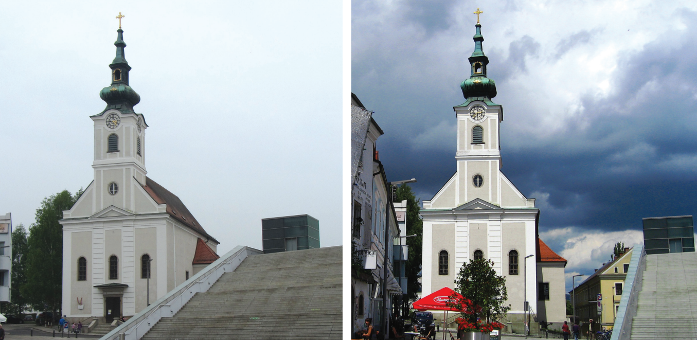
il. 1,2 Linz – Josefskirche Stadtpharre Urfahr i fragment Ars-Electronica Center (fot. MP) / Linz – Josefskirche Stadtpharre Urfahr and a fragment of the Ars-Electronica Center (phot. MP)
