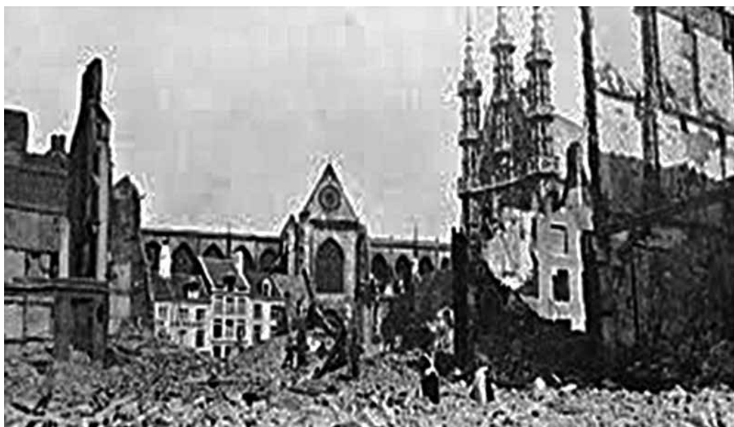
8. Plac Ludowy. W głębi Kościół Saint-Piere, po prawej Ratusz 11 .
