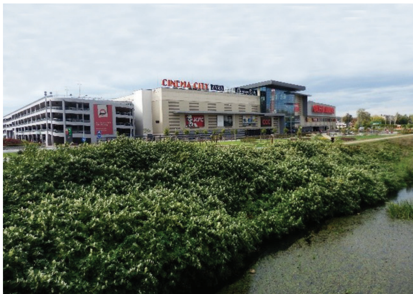
Il. 4. Widok na „Galerię Jurajską” od strony Warty (fot. autor, 2018)
