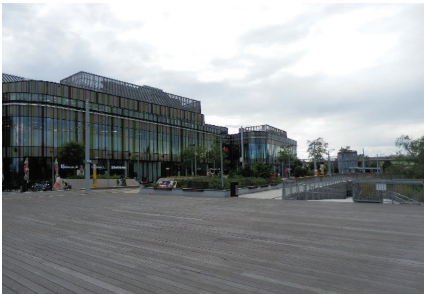
II. 7. Przestrzeń publiczna po stronie wschodniej centrum handlowego „Šantovka” (fot. autor, 2018)
