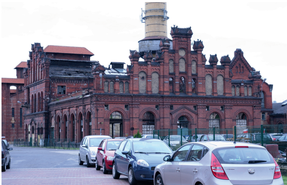
Budynek zakładu gazu wodnego w gazowni poznańskiej w 2012 r. (Źródło: M. Urbaniak).
