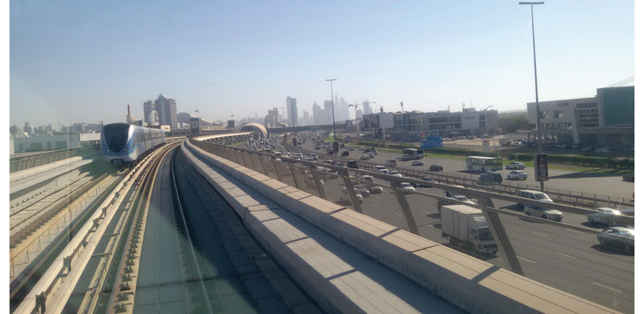
Il. 1. Bezobsługowe, w pełni zautomatyzowane i klimatyzowane metro usytuowane nad 14-pasmową autostradą (fot. autora)/Uncrewed, fully automated and air conditioned metro rail situated above a 14-lane freeway. (phot. by the author)
