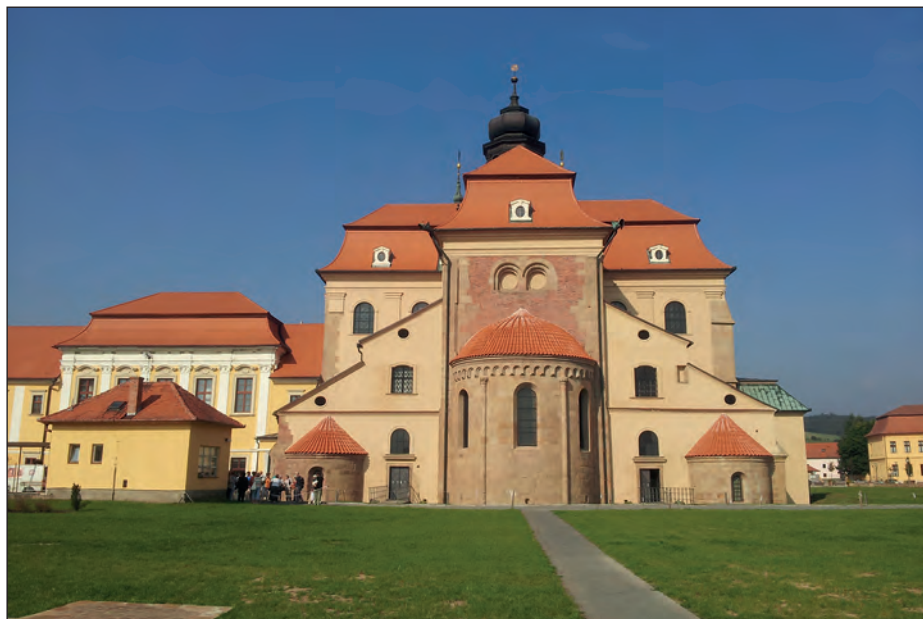
Fot. 5. Bazylika pw. Wniebowzięcia NMP w Velehradzie. Widok od wschodu – widoczne romańskie relikty architektoniczne (fot. R. Faracik)
