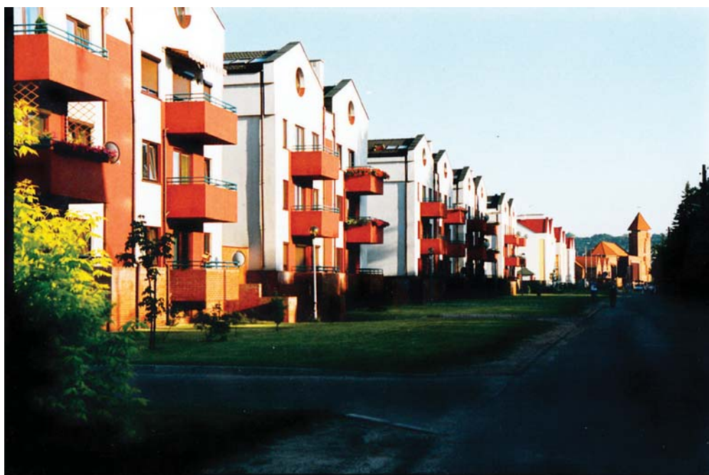
Kraków, ulica Wesele, zespół mieszkaniowy z kościołem. Autorzy projektu: Małgorzata Buratyńska – Seruga, Wacław Seruga Fot. J. Zych / Craców, Wesele street, residential complex with a church. Designed by: Małgorzata Buratyńska-Seruga, Wacław Seruga. Photo: J. Zych
