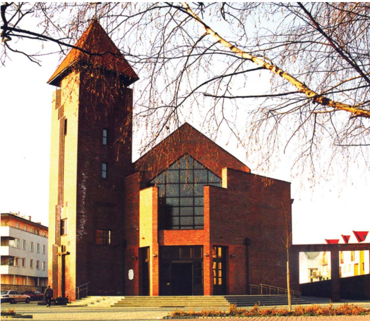
il. 8,9. Kościół rzymsko-katolicki p.w. św. Wojciecha wraz z zapleczem katechetyczno-mieszkalnym. Kraków ul. św. Wojciecha 4 1995–2000 r. Autorzy: Wacław Seruga, Małgorzata Buratyńska-Seruga. Fot. Wacław Seruga Ill. 8,9. St. Adalbert’s Roman Catholic Church with residential and teaching facilities. Cracow, św. Wojciecha 4 street 1995–2000. Authors: Wacław Seruga, Małgorzata Buratyńska-Seruga. Photo: Wacław Seruga
