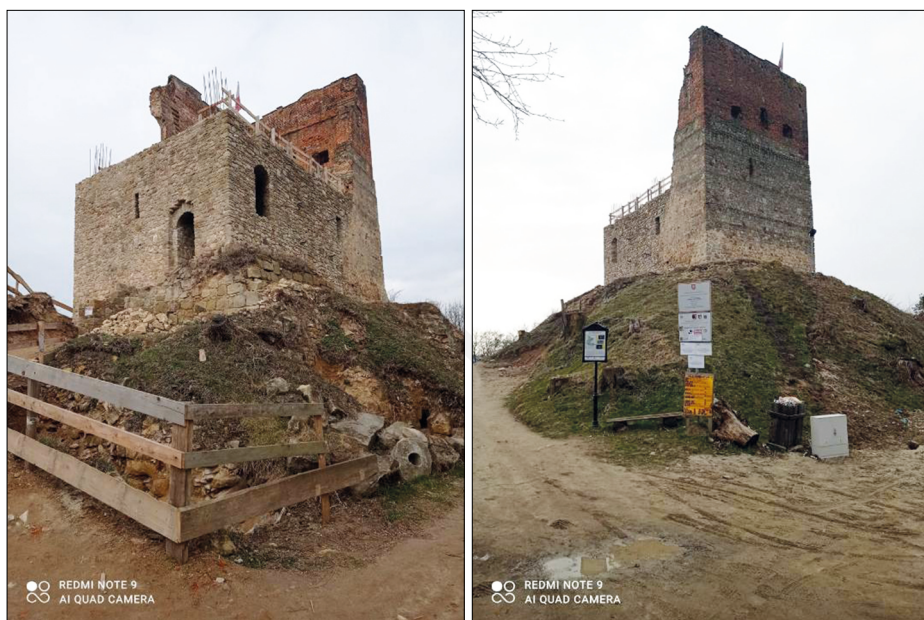
Fot. 2. Prace nad zabezpieczeniem ruin zamku w Melsztynie (fot. M. Kwiek)
