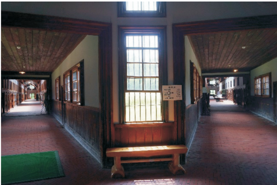
Fot. 2. Abashiri Prison Museum – wejście umożliwiające obserwację więźniów (fot. L. Czernichowska-Kramarz)
