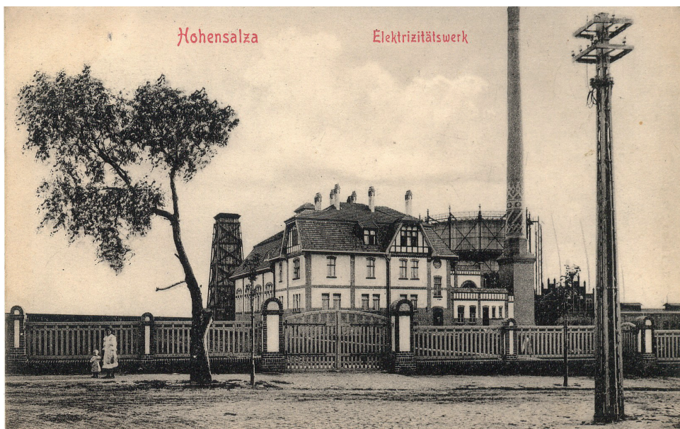
Ryc. 1. Elektrownia parowa z 1909 r. w Inowrocławiu (ze zbiorów autora)
