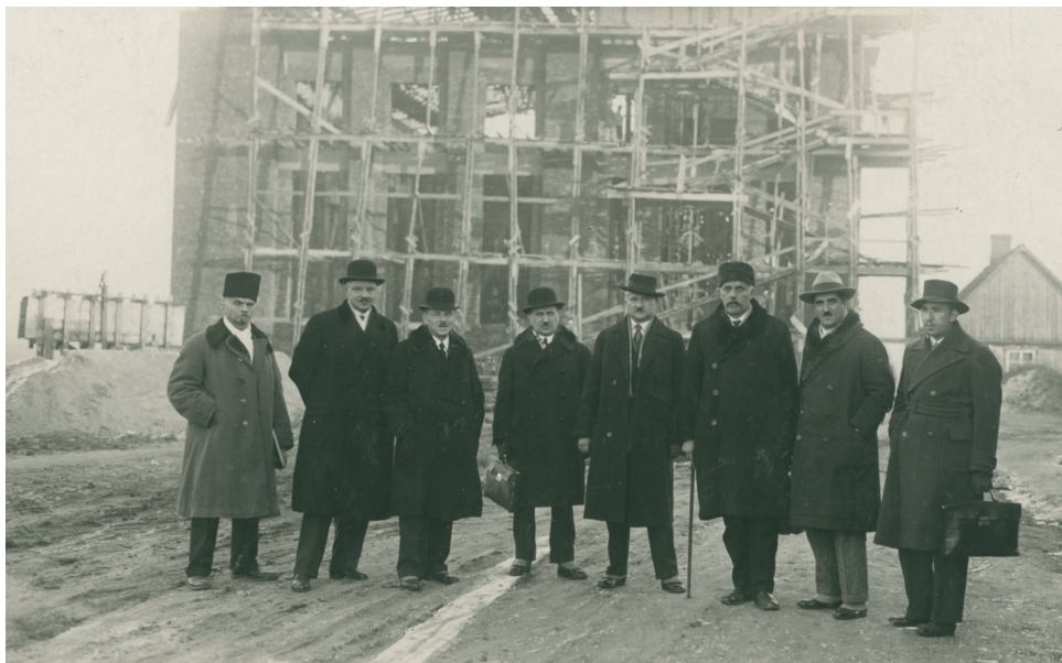
Ryc. 14. Okręgowy Zakład Elektryczny Miasta Kalisza w trakcie budowy na początku lat trzydziestych XX w. (źródło: Archiwum Państwowe w Kaliszu, Spuścizna Tadeusza Martyna z Kalisza, sygn. 119)
