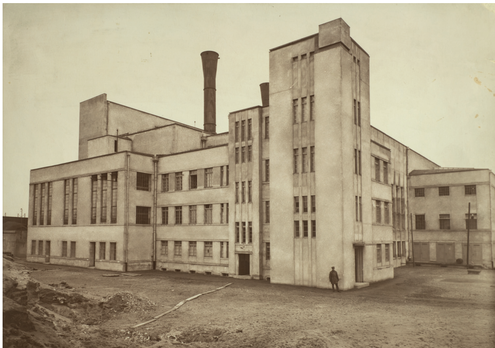
Ryc. 8. Elektrownia Miejska na Jachcicach w Bydgoszczy, lata trzydzieste XX w. (źródło: Muzeum Okręgowe w Bydgoszczy)
