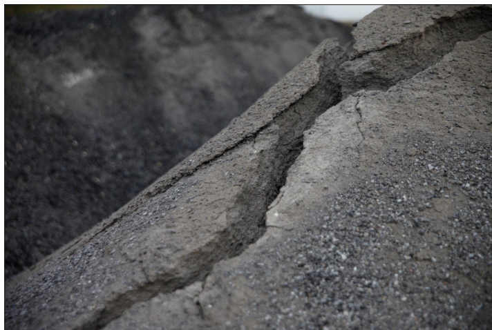
Fot. 3. Spękana ziemia na hałdzie w Panewnikach (fot. A. Karpień)
