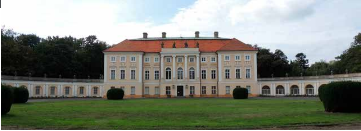
6. Pałac Mielżyńskich w Pawłowicach, 1779–1792, widok na fasadę, stan z 2021 r. Fot. Kinga Sibilska
