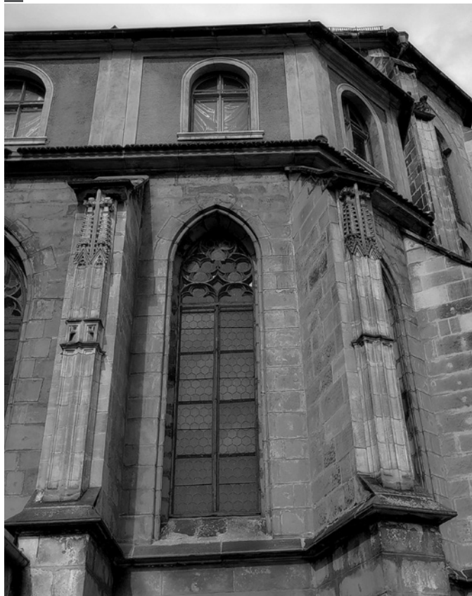
10. Kłodzko, kościół Wniebowzięcia NMP, okno ściany wzdłużnej południowej apsydy i flankujące je przypory. Fot. Jan Widtak
