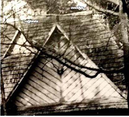
Ryc. 17. Leśniczówka Kaczew (d. dworek myśliwski). Widok zdobień szczytów dymnika, ryzalitu (A) oraz zakończeń dachu naczółkowego (B) (oznaczenia strzałkami). Dymnik ozdabiał pazdury deskowy o płomienistym grocie, prawdopodobnie taki sam wzór znajdował się również na szczycie ryzalitu. Przy naczółkach osadzono pazdury z kantówki, opracowane czterostronnie uskokowo, ale z nieczytelnym zwieńczeniem. Przełom lat trzydziestych i czterdziestych XX w. (fragmenty fot. ze zbiorów Iwony Dymel)
