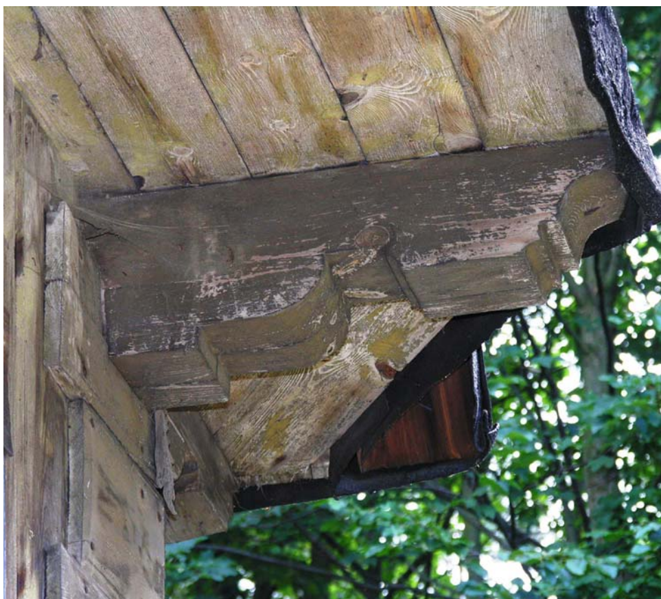
Ryc. 18. Leśniczówka Kaczew (d. dworek myśliwski). A – widok balustrady werandy wypełnionej tralkami deskowymi wyrzynanymi. B – belka narożna okapu, na wysokości ryzalitu, o profilowanym spodzie będącym układem ćwierćwałka i wklęsek rozdzielonych płatkami i uskokami prostopadłymi (fot. Andrzej Cichy, 2007 r.)
