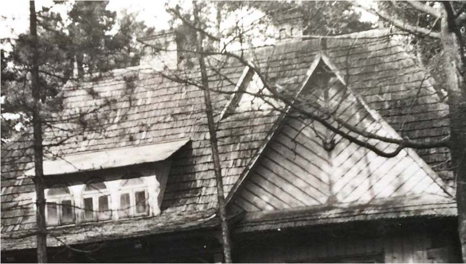
Ryc. 19. Leśniczówka Kaczew (d. dworek myśliwski). Połączenie zachodnia dachu naczółkowego z widokiem okien dachowych (wygląd), dymnika (niezachowanego) oraz szczytu ponad ryzalitem z wyeksponowanym malarsko jodełkowym układem szalunku. Fotografia z przełomu lat trzydziestych i czterdziestych XX w. (fragment fot. ze zbiorów Iwony Dymel)
