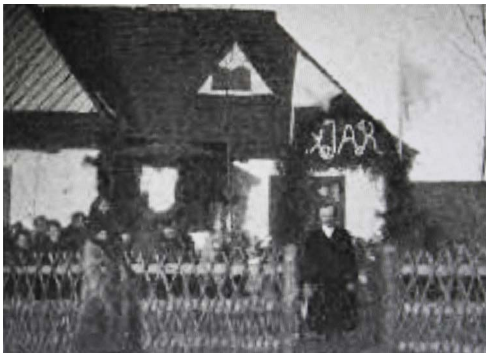
Ryc. 24. Fragment elewacji frontowej ochronki z widokiem szczytu z przyczółkiem zdobionego jodełką oraz dymnika. Przed budynkiem w wejściu ogrodzenia przyozdobionego łukiem wykonanym z gałązek iglastych i z monogramem „XJAR” (ks. ks. Janusz i Anna Radziwiłłowie) stoi włościanin Ludwik Kozieł – opiekun ochronki (źródło: Ochronka na wsi , „Tygodnik Ilustrowany” 16.03.1907, nr 11, s. 232)
