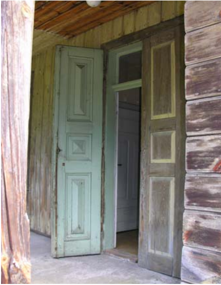
Ryc. 21. Leśniczówka Kaczew (d. dworek myśliwski). Wyjście na werandę. Drzwi zewnętrzne zamykane są tylko od wnętrza, jak okiennice (fot. Andrzej Cichy 2007 r.)
