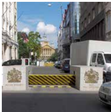
Zdjęcie 10. Przenośna zapora drogowa typu DSC1100 przed Ambasadą Wielkiej Brytanii w Budapeszcie.
