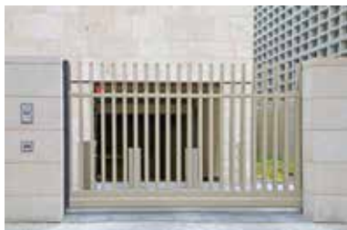
Zdjęcie 11. Ażurowa brama wjazdowa przed zjazdem do garażu w Ambasadzie Republiki Turcji w Berlinie, za bramą są widoczne ruchome słupki zabezpieczające.
