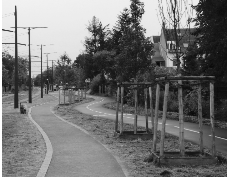
Il. 7. Strasburg – Robertsau. Własny korytarz tramwaju, z drogą rowerową i pieszą; fot.: Jacek Wesółowski, 2020
