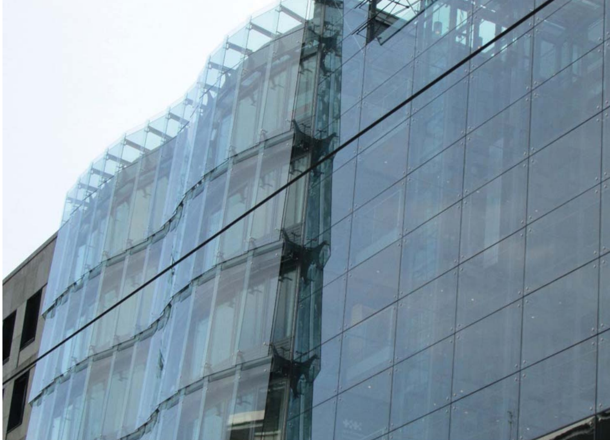
Il. 1. Detale elewacji Berliner Sparkasse-Beratungcenter przy Friedrichstraße 148 W Berlinie. Widoczne połączenie fasady kurtynowej bez ram konstrukcyjnych i ściany dwupowłokowej (szklenia uchylone, działające jako izolatory przejmujące nagrzane promienie słoneczne). Źródło: materiały autora / Berliner Sparkasse-Beratungcenter elevation detail at the Friedrichstraße 148 Street in Berlin. The visible connection of a curtain wall without the construction frames and two-layered wall (opened glazings, working as insulators that receive the heat from sunlight). Source: Author's own material
