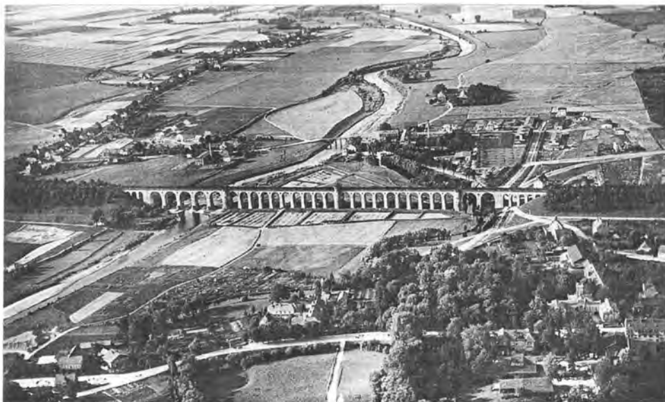
Ryc. 4. Wiadukt kolejowy na rzece Bóbr w Bolesławcu
