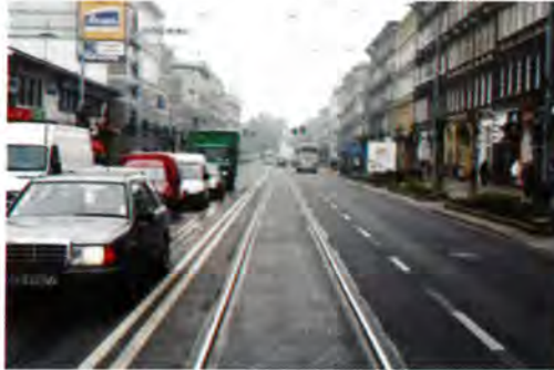
Fot. 3 Ulica Krzywoustego w Szczecinie po przebudowie (2006 r.)
