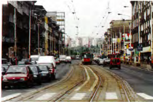
Fot. 2. Ulica Krzywoustego w Szczecinie przed przebudową (2000 r.)
