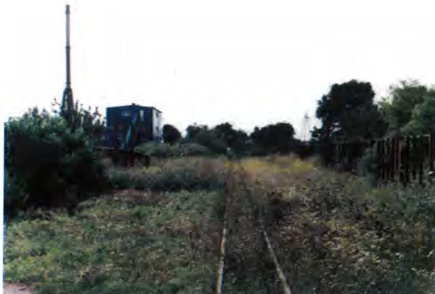
Fot. 4. Częściowo rozebrany odcinek Wierzchosławice – Tuczo, stan lipiec 2003 r.
