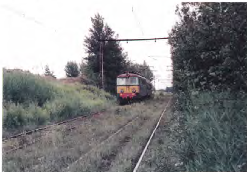
Fot. 1. Pasażerski pociąg służbowy na magistrali północnej kp „Szczakowa” w 2001 r.
