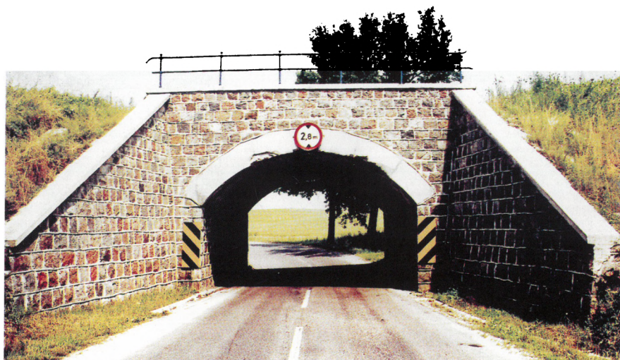
Wiadukt kolejowy linii Skórcz - Czersk pod Zelgoszczą (fot. T. Palmowski)
