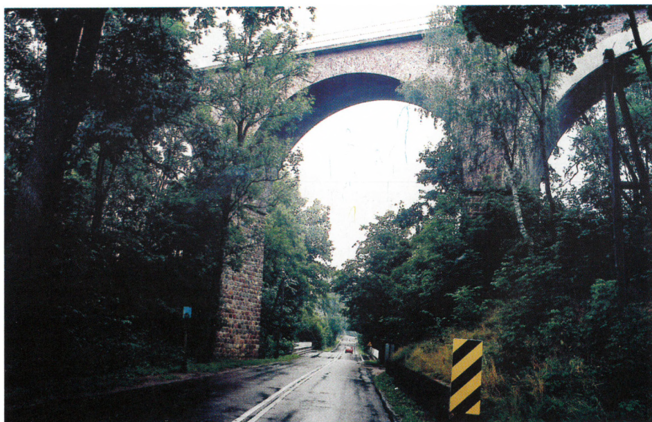
Wiadukt nieczynnej linii kolejowej Koronowo Pruszcz Bagienica koło Buszkowa (fot. T. Palmowski)
