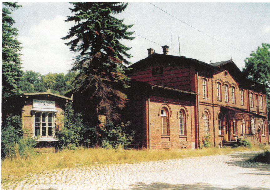
Dawny dworzec w Szczawnie Zdroju na zamkniętej obwodnicy Wałbrzycha (fot. T. Lijewski)
