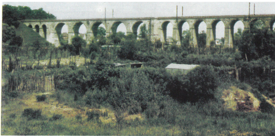
Najdłuższy w Polsce kamienny wiadukt kolejowy przez dolinę Bobru koło Bolesławca (fot. T. Lijewski)
